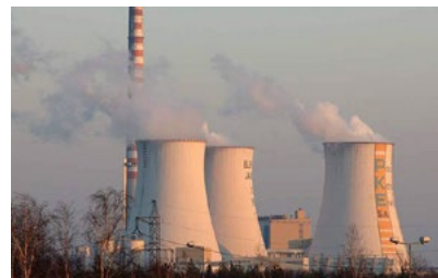
Elektrownia Jaworzno, Polska
