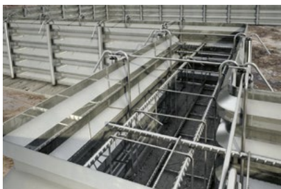
Fundamenty i Ławy
